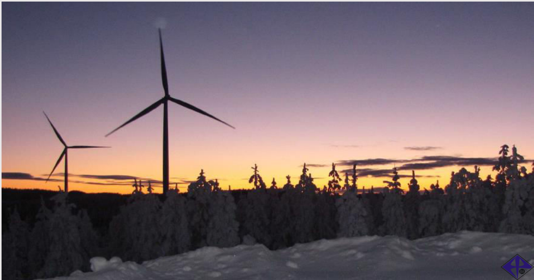
Vjetroelektrana Brahehus, Švedska Snaga: 20,7 MW
