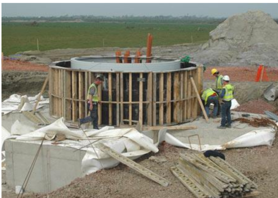
Slika 5. Uobičajeno temeljenje vjetroturbine
