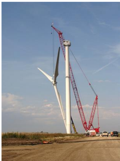
Slika 6. Sklapanje vjetroturbina
