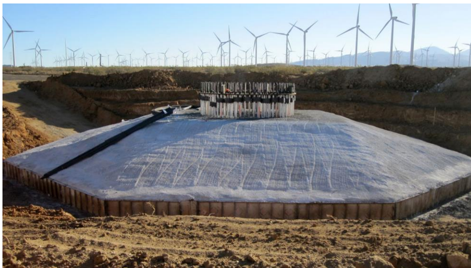
Slika 4. Ogleđni primjer temelja vjetroturbine
